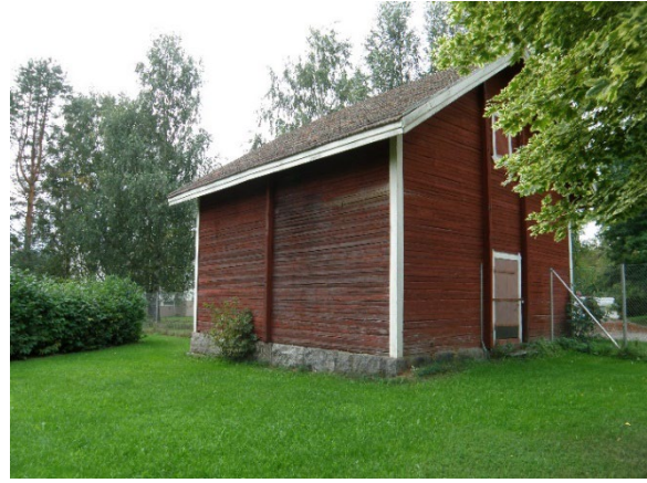
Vanha aitta, joka sijaitsee Reikonlinnan eteläpuolella. Kuva: Helena Väisänen
