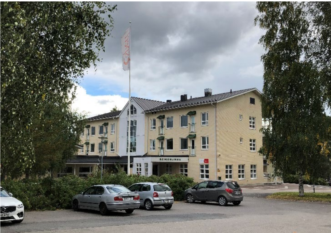
Reikonlinna, kerrosala 2662 kem 2 , valmistunut vuonna 2000. Kuva: Urjalan kunta.
