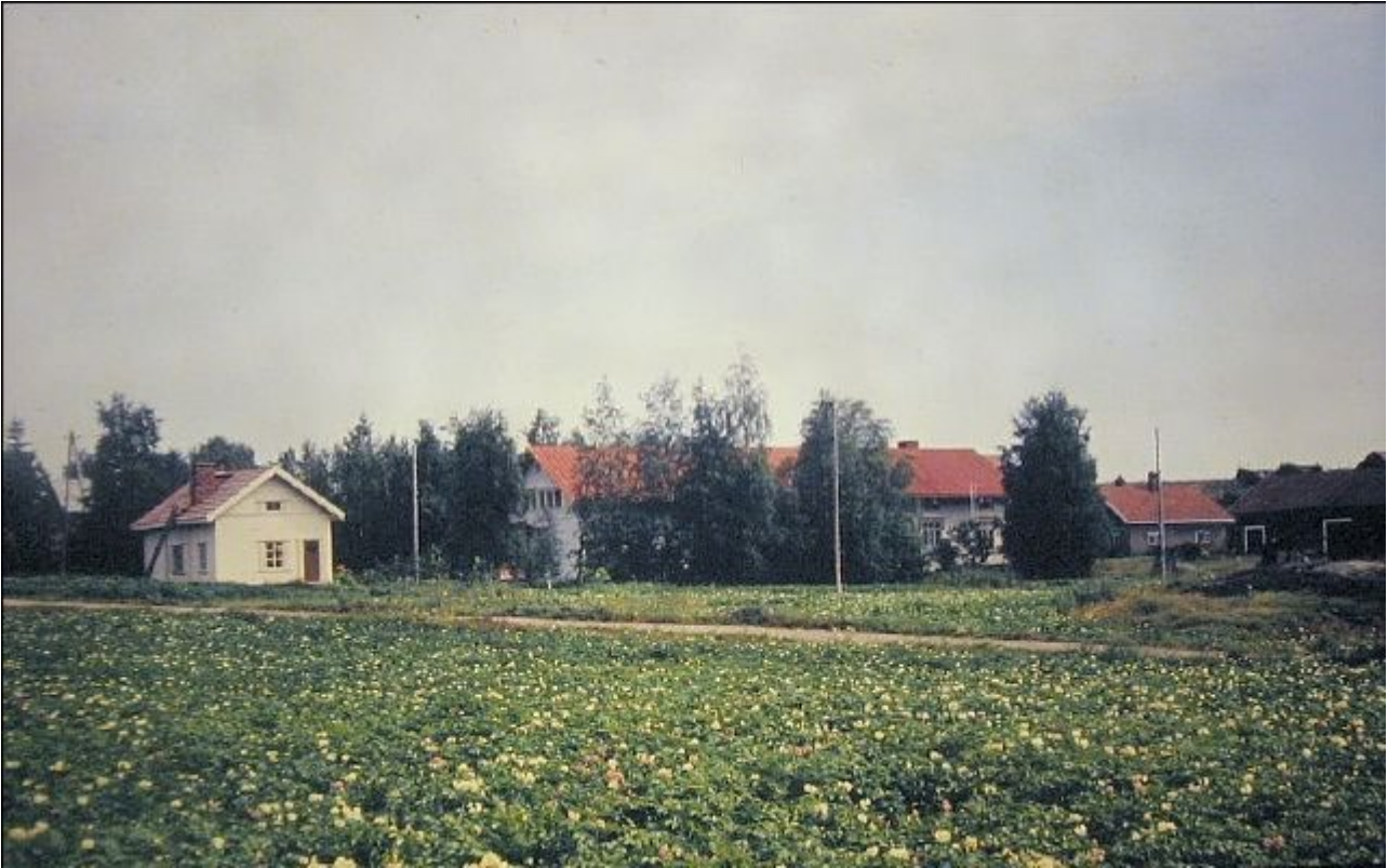
Kansakoulun keittola (alun perin ruokailuhuone/sauna) ja oikealla entinen lastenkoti, joka toimi vuosi 1924-1976 kansakouluna (rak. 1888, purettu 2008). Kuva: Matti Tyry.
