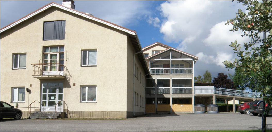
Vanhainkoti etelästä. Kuva: Urjalan kunta.
