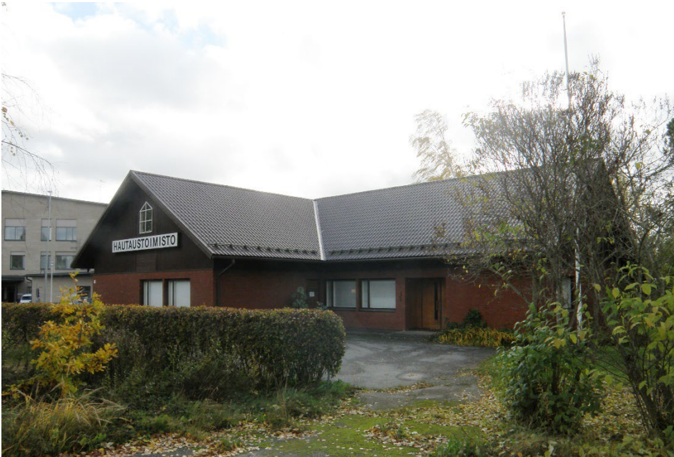
Vanhainkodintie 3, asuinrakennus ja hautaus toimisto. Kuva: Urjalan kunta.
