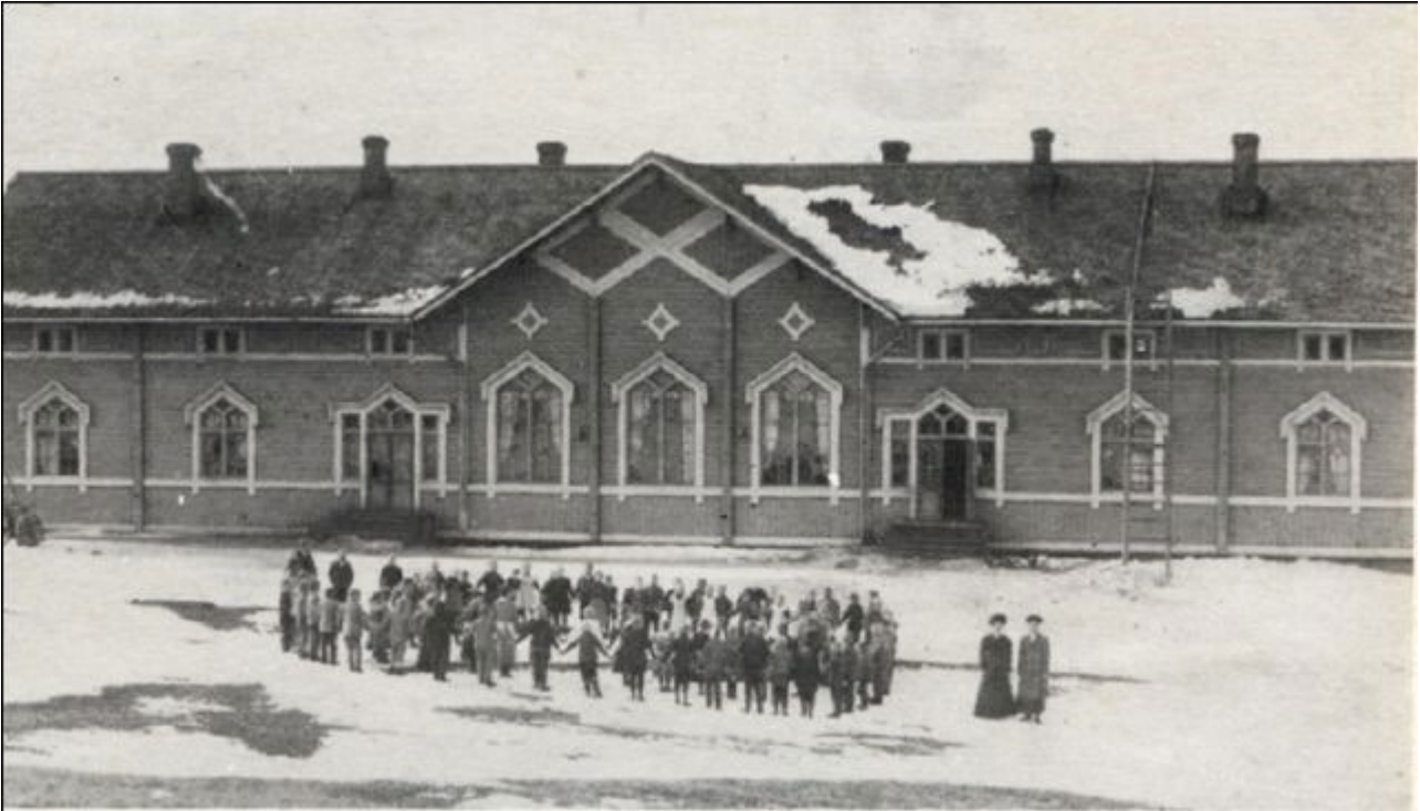
Lastenkoti (rak. 1888), joka toimi kouluna vuosina 1924-1976. Rakennus purettiin vuonna 2008. Kuva: Simo Lallukan kokoelma.
