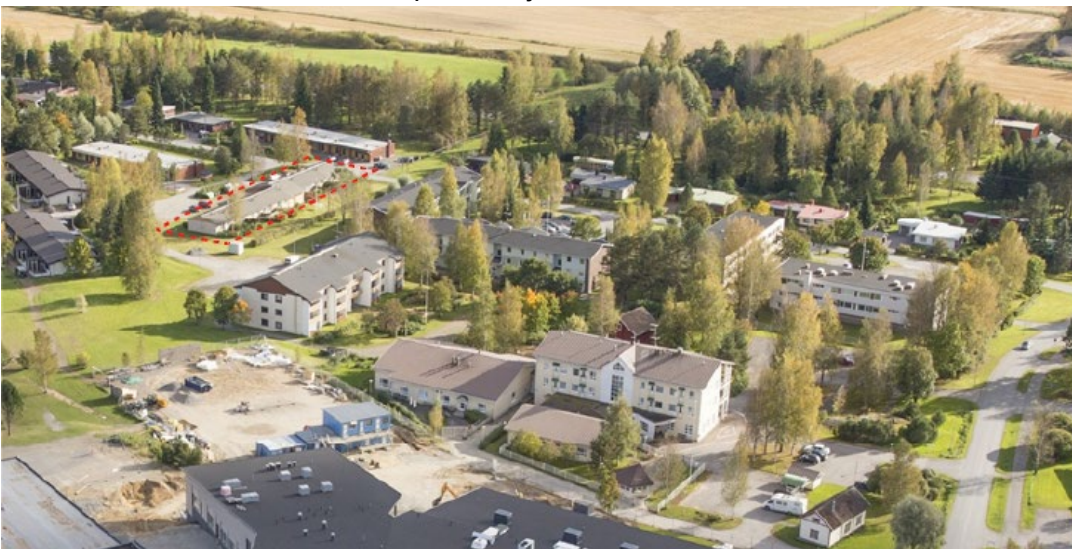
Viistokuva, jossa Rivitie 2 on rajattu punaisella katkoviivalla. Kuva: Urjalan kunta.
