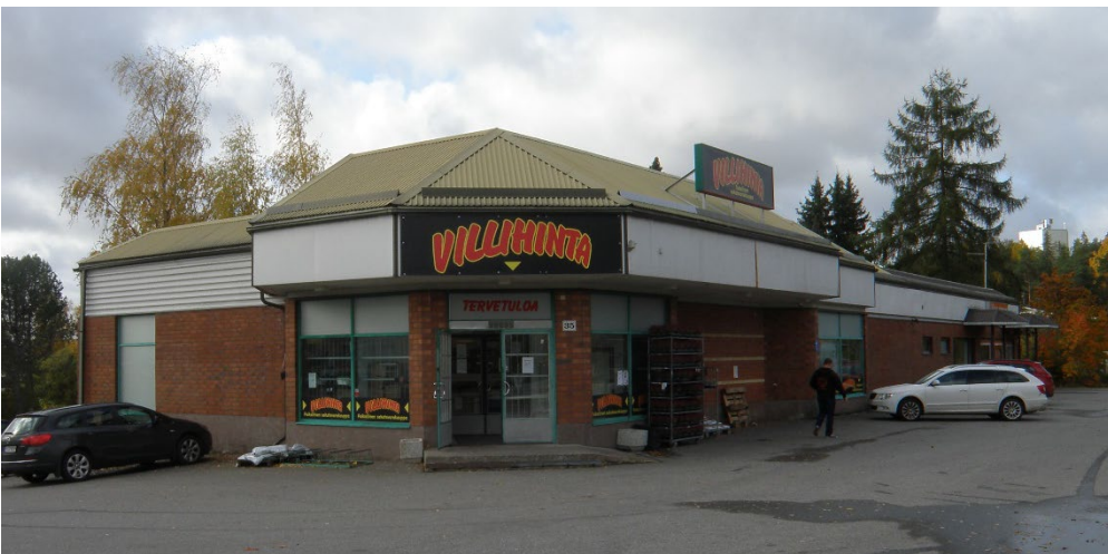
Urjalantie 35 asuin- ja liikerakennus nähtynä Urjalantien ja Vanhainkodintien risteuksen suunnasta. Kuva: Urjalan kunta.
