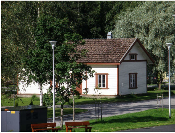
Vanha kansakoulun keittola (alun perin ruokailuhuone/sauna). Rakennus toimii nykyisin koulun varastotalana. Kuva: Urjalan kunta
