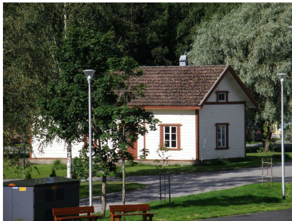
Vanha kansakoulun keittola (alun perin ruokailuhuone/sauna). Rakennus toimii nykyisin koulun varastotalana. Kuva: Urjalan kunta
